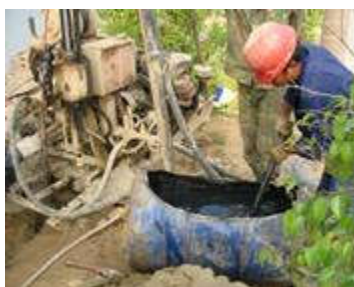
图五 电极安装完毕后，外部填充材料与水按照1:1的比例充分搅拌。
