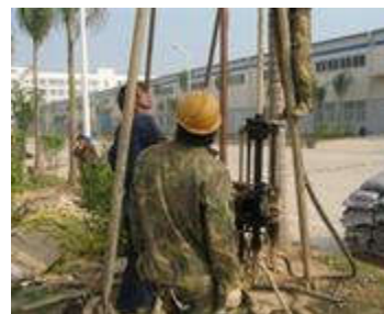
图三 放入电解离子接地极
