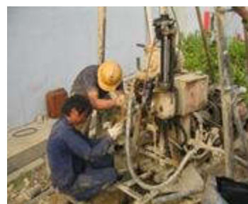
图六 连接高压泵，用高压将外部填充材料打入深井，灌满为止。
